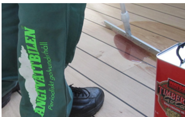
Grunnoljing av skipsgulv
