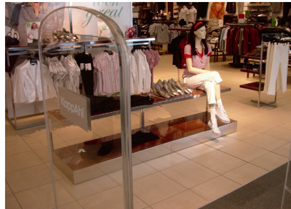
Installationsbehandlat granitkeramikgolv, KappAhl
