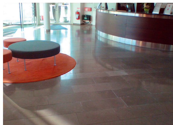
Twisterbehandlat kalkstensgolv, Scandic City Linköping
